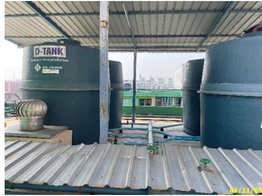
ถังสำรองน้ำอุปโภค-บริโภคชั้นดาดฟ้า
