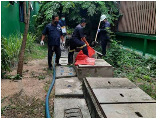
ทำความสะอาดบ่อบำบัดน้ำ (Manhole)
